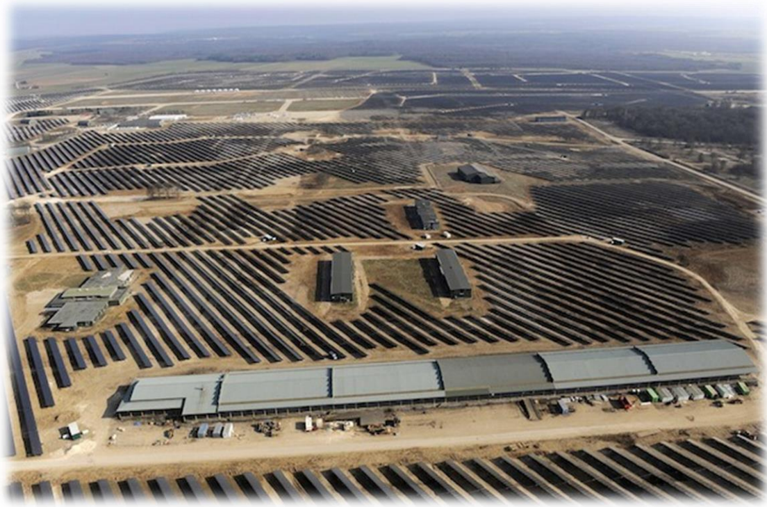
Figure 12 : photographie aérienne de la centrale Toul-Rosières
