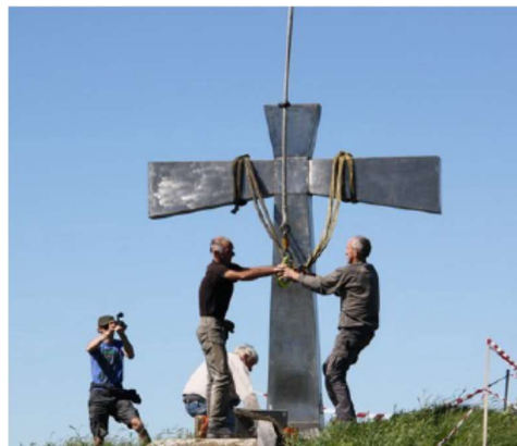
La pose de la croix (17 juillet 2016)
