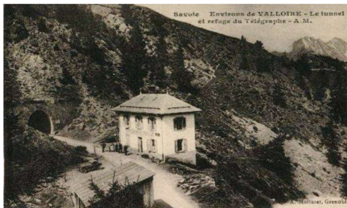
Le tunnel du Télégraphe construit en 1876 (source : Association Valloire nature et avenir)
