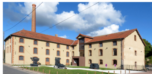
CIAP La Tuilerie Sauvard, La Guerche sur Aubeois (18), Spirale Architecture
