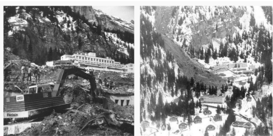
Fig II.II.a.1. Photographies du sanatorium Le Roc des Fiz dans les jours suivant le glissement de terrain, 1970. Le Dauphiné Libéré, 2019.
