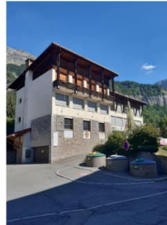
Entrée sur le CIAP avec les moloks
