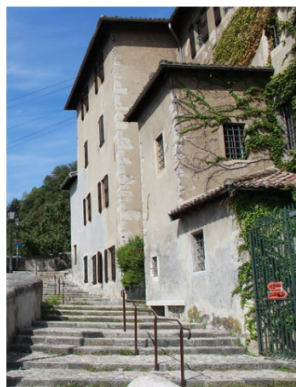
Montée de Chalemont, Grenoble (38), grenoble tourisme.
