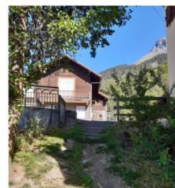
Escaliers débouchant sur la rue de Charbonnière
