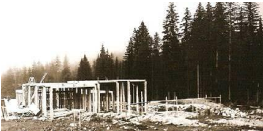
Fig I.1.c.3. Photographie des fondations du projet de Plaine Joux Mont Blanc, détruites en 1985 (Manin, 2015).
