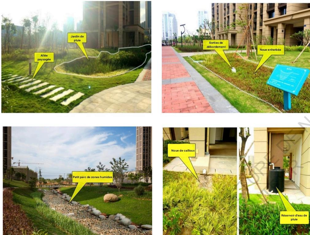
Figure 77 : Photographies de quelques installations terminées du projet de la ville éponge dans la zone résidentielle de Yangtang (CRR, 2020)
