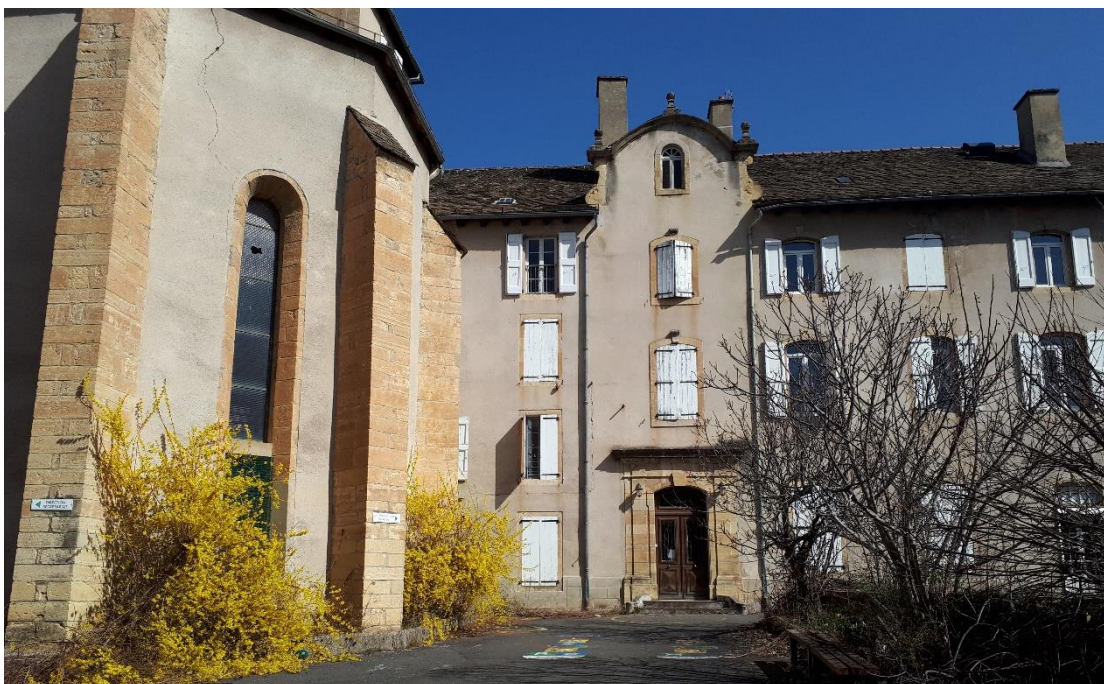
Photo 3 : Entrée Sud de l'Îlot Châtillon donnant sur l'ancien couvent - Source : Florian Behague
