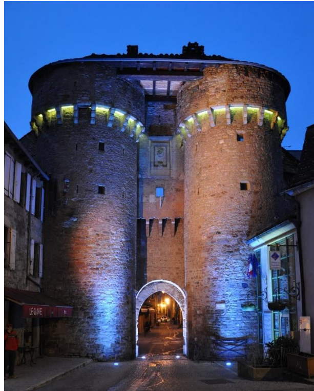
Photo 4 : Éclairage de la Porte du Soubeyran à Marvejols - Source : Ville de Marvejols
