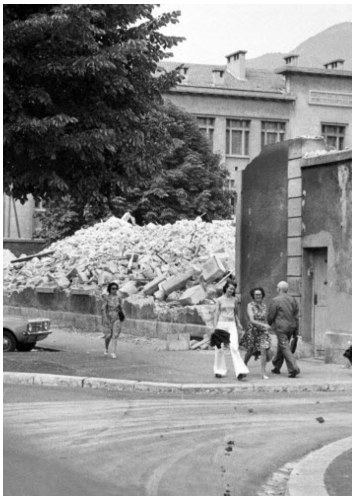
Démolition de la Caserne Hoche (1976)
