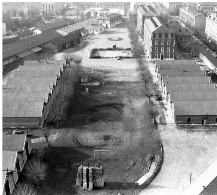
Photographie de la caserne Hoche avant sa démolition (janvier 1976) crédit photo : Le Dauphiné Libéré
