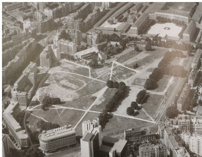
Les 9ha dégagés par la démolition de la caserne aux portes du centre ville crédit photo : Le Dauphiné libéré
