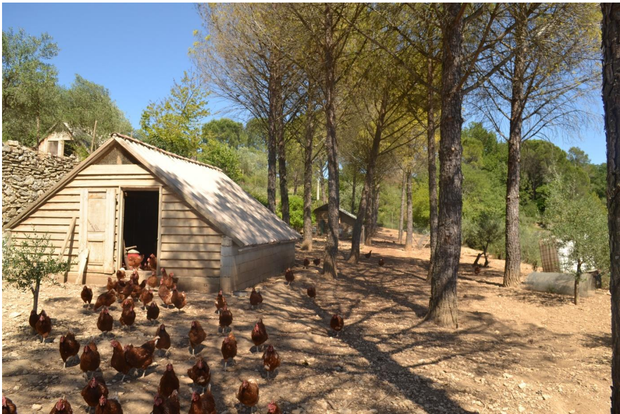
Figure 17: Poulaillers en bois autoconstruits chez l'éleveur 1 (source : personnelle).
