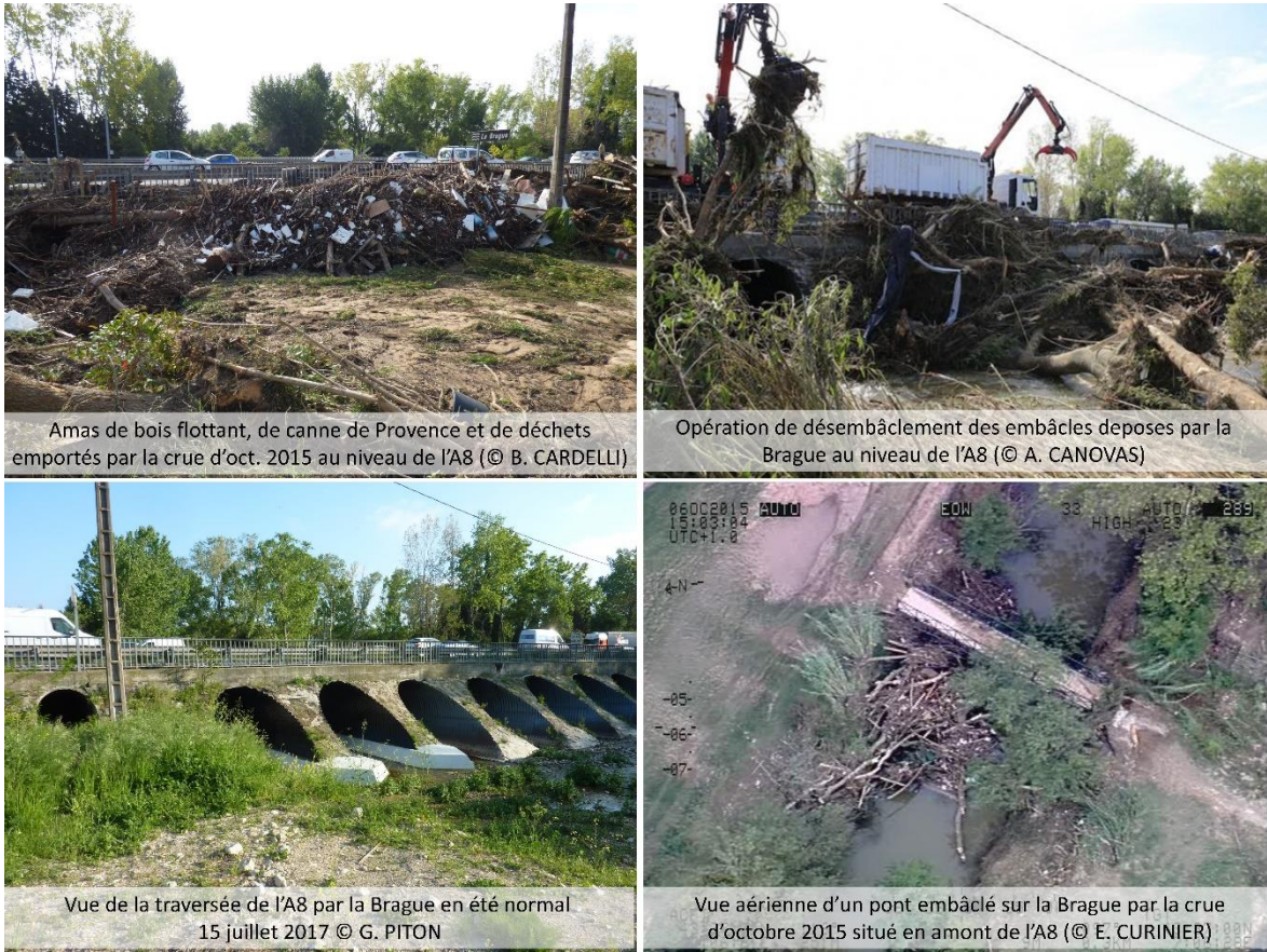
Figure 3 : Images prises après la crue de Oct. 2015 au niveau de l'autoroute A8 (panneau supérieur) à comparer avec l'image en état normal (en bas à gauche). Plusieurs ponts ont ainsi été obstrués sur la Brague (par exemple image en bas à droite)
