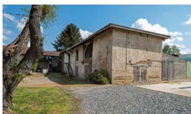
Vue du sud-est : grange et fenil desservi par un escalier extérieur, écurie ou porcherie Phot. Michel Pérès IVR84_20220100141NUCAQ
