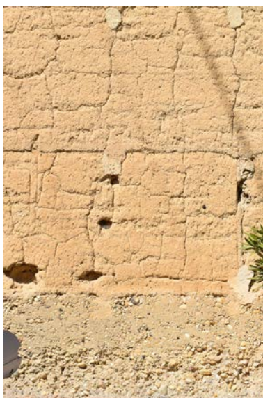
Détail : pisé avec soubassement béton de chaux Phot. Magali Delavenne IVR84_20220100215NUCA
