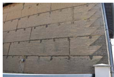
Détail : renforts d'angle béton de chaux Phot. Magali Delavenne IVR84_20220100221NUCA
