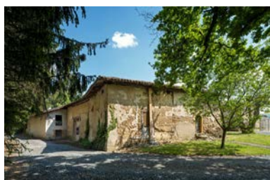
Vue d'ensemble nord-ouest, depuis le chemin Phot. Michel Pérès IVR84_20220100143NUCAQ
