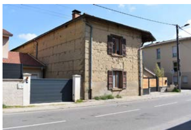
Vue d'ensemble nord-ouest, façade postérieure aveugle Phot. Magali Delavenne IVR84_20220100220NUCA
