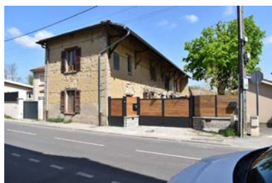
Vue d'ensemble sud-ouest, pignon sur rue Phot. Magali Delavenne IVR84_20220100219NUCA
