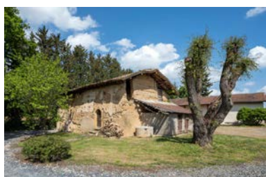
Bâtiment ouest, probablement plus ancien Phot. Michel Pérès IVR84_20220100140NUCA
