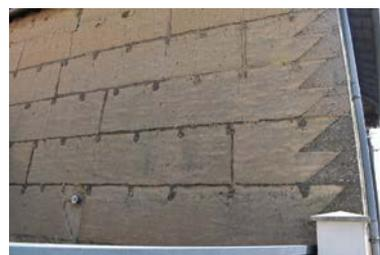
Détail : renforts d'angle béton de chaux
