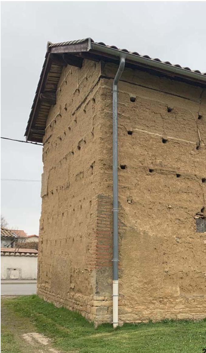
1. fissures de retrait au séchage coulures du pisé
