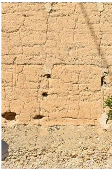
Détail : pisé avec soubassement béton de chaux
