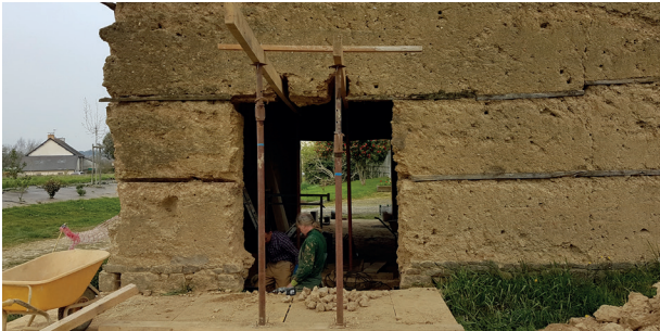
Ouverture mur bauge, maison terre, alentour Rennes
