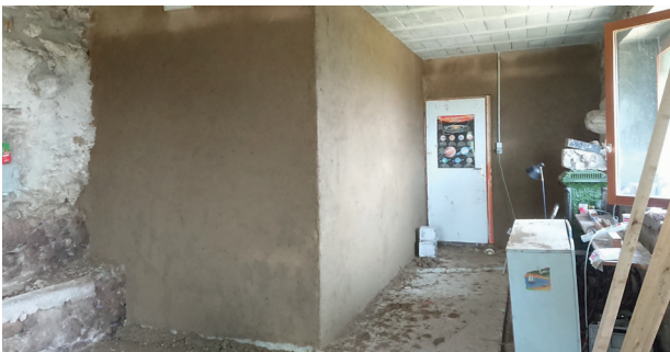
Isolation terre paille/enduits, Thibault, Hautes Savoie
