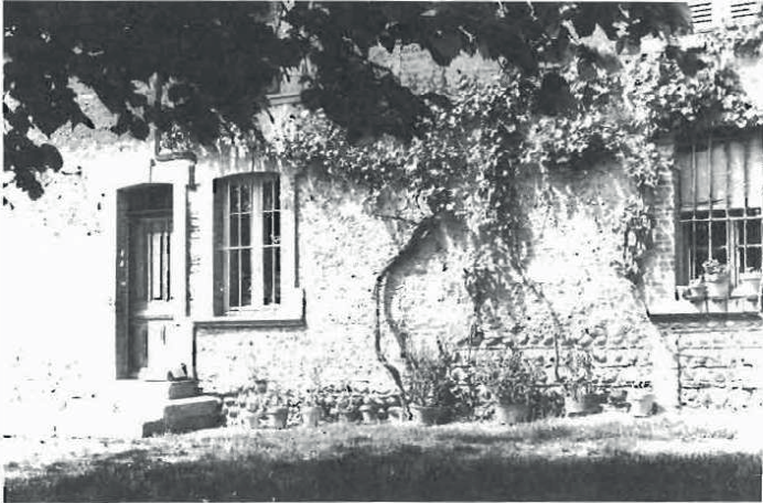
FIGURE 47 : FAÇADE DE LA PARTIE HABITATION
