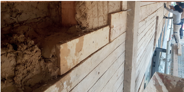
Bauge coffrée, Denis Mallejac, Rennes
