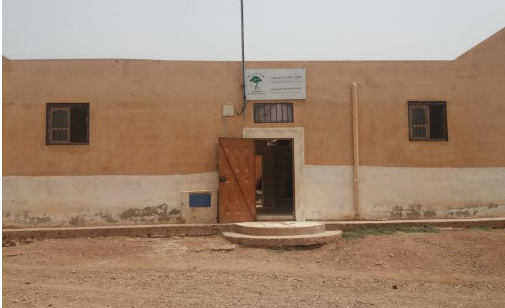
Figure 15: Devanture d'une coopérative de concassage dans une zone rurale. Source: auteur
