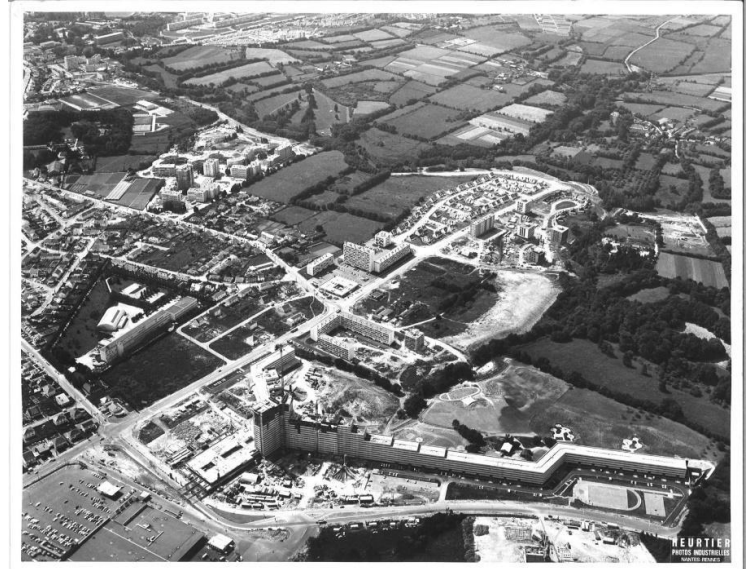
Figure 14 : Photo de la construction du Sillon de Bretagne (sans date). Source : Heurtier
