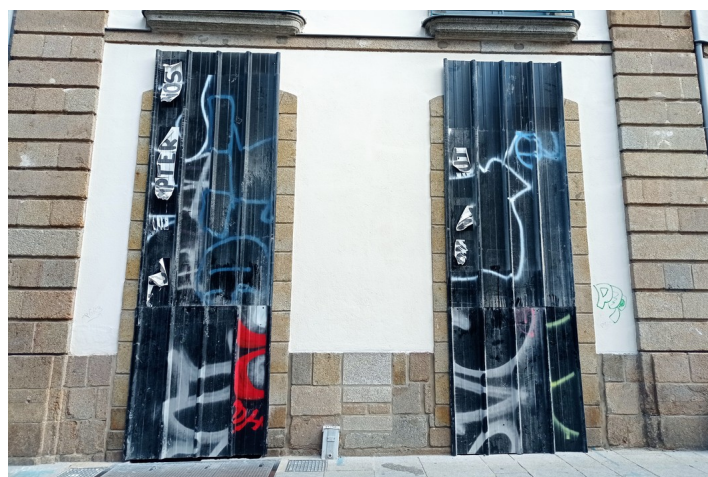
Figure 9. Photographie de palissades de chantier qui ont été déplacées mais sur lesquelles sont encore visibles les restes d'un collage (Source : autrice, 6 juin 2022).
