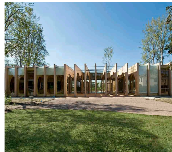
fig. 39 : patio de la crèche de Guastalla au centre de la structure / Mario Cucinella Architects. Image © Moreno Maggi
