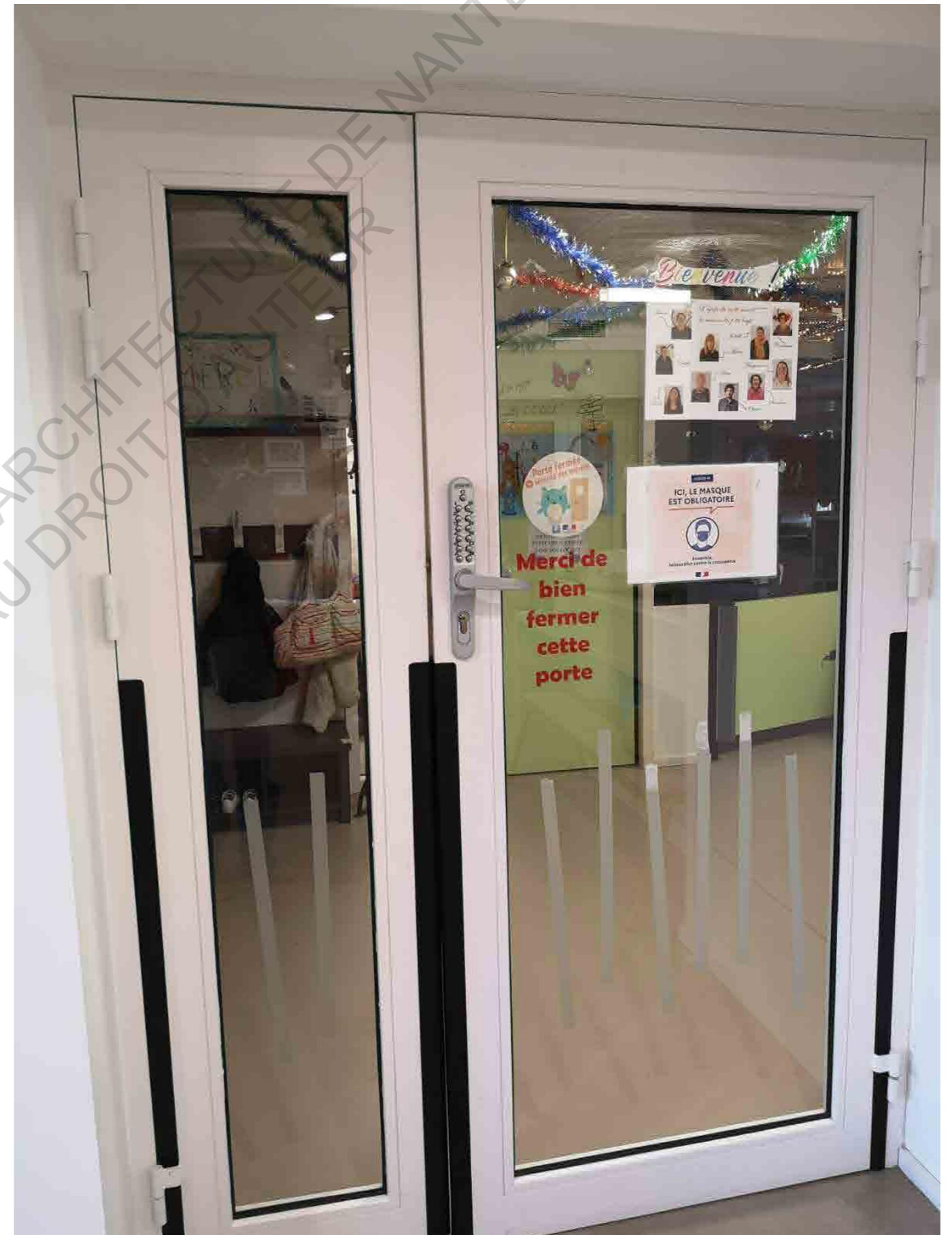
fig. 20 : la porte vitrée d'accès au multi-accueil d'Aigrefeuille (image personnelle)
