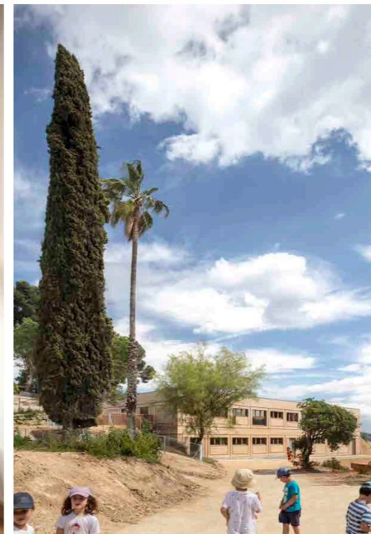
fig. 53 : les plantations adaptées au climat méditerranéen et le sol en terre de la crèche El Til·ler / Eduard Balcells + Tigges Architekt + Ignasi Rius Architecture. Image © Adrià Goula
