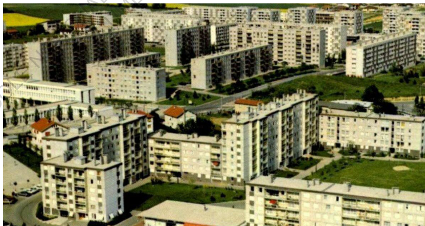
Cité du Bel-Air 1, à St-Priest (est de Lyon) construit en 1968. Photo d'archive.
