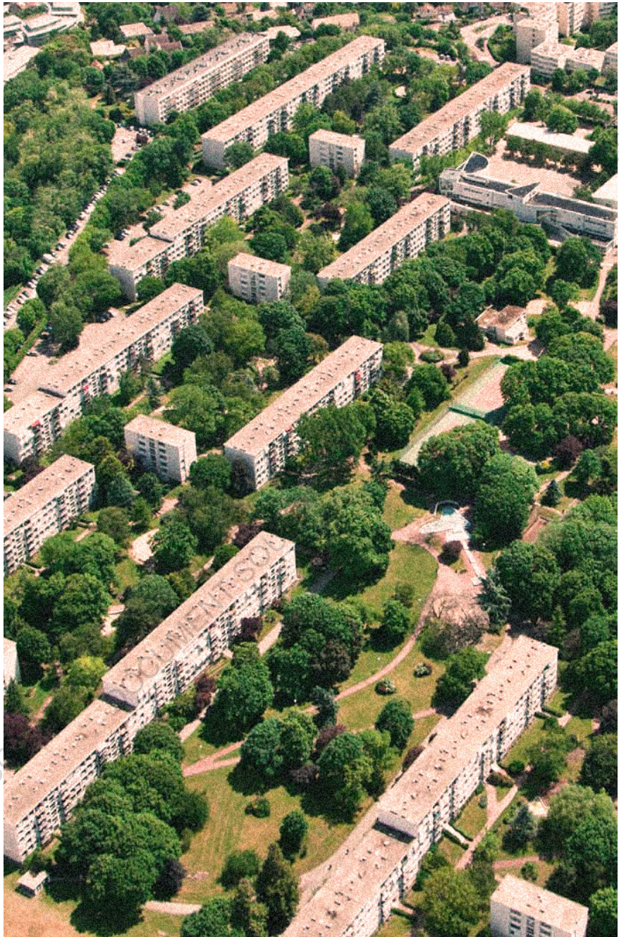
La cité des Grandes Terres à Marly-le-Roi, Marc Lods. Vue aérienne.
