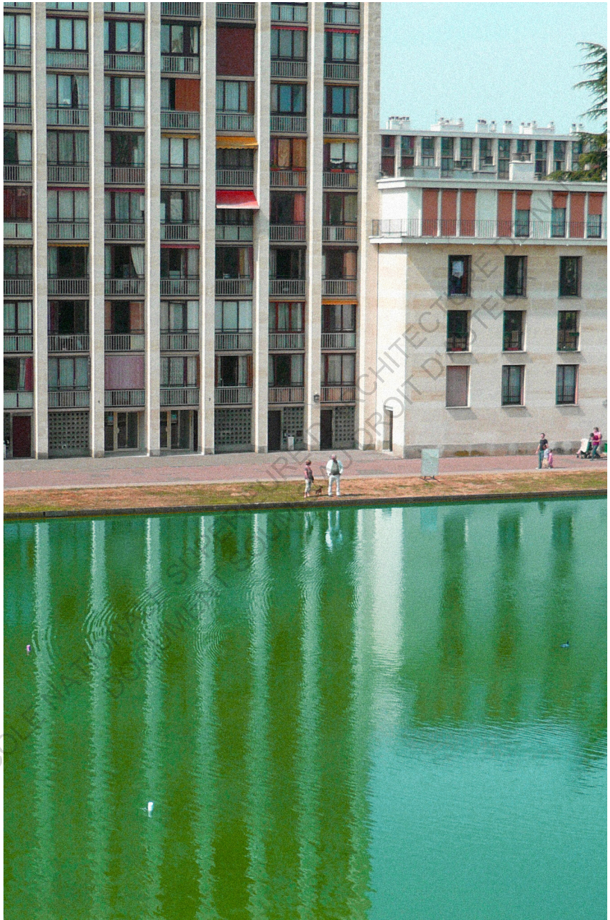
Grands ensembles de Meudon-La Forêt, Fernand Pouillon. Photographie : Gilles Fiant.
