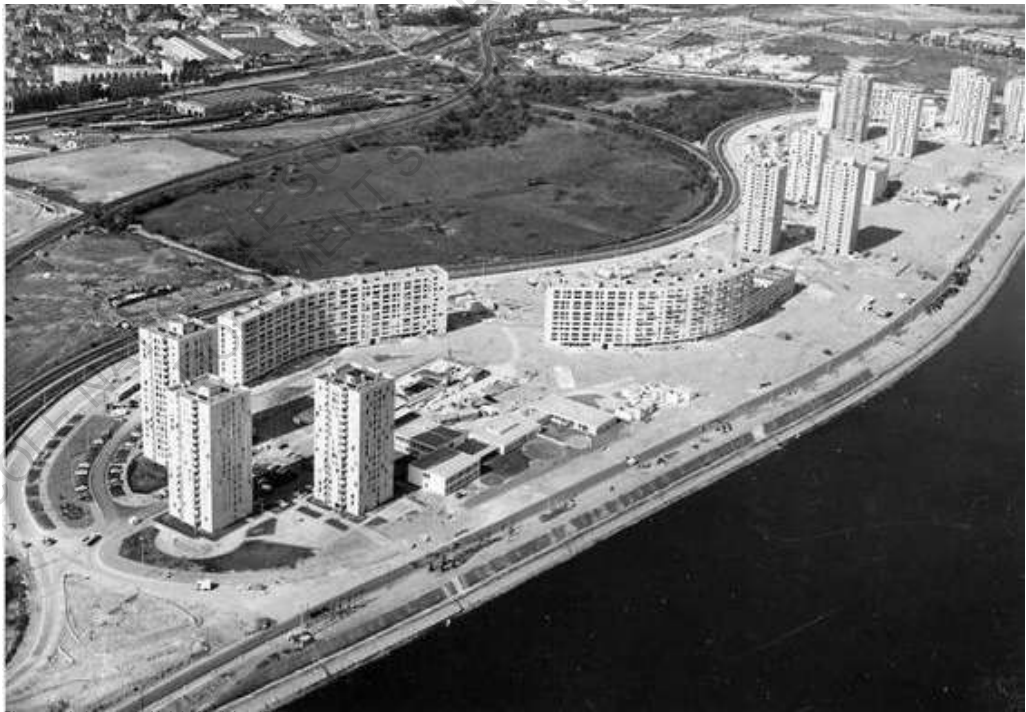
Chantier de la cité de Malakoff- début 1967
