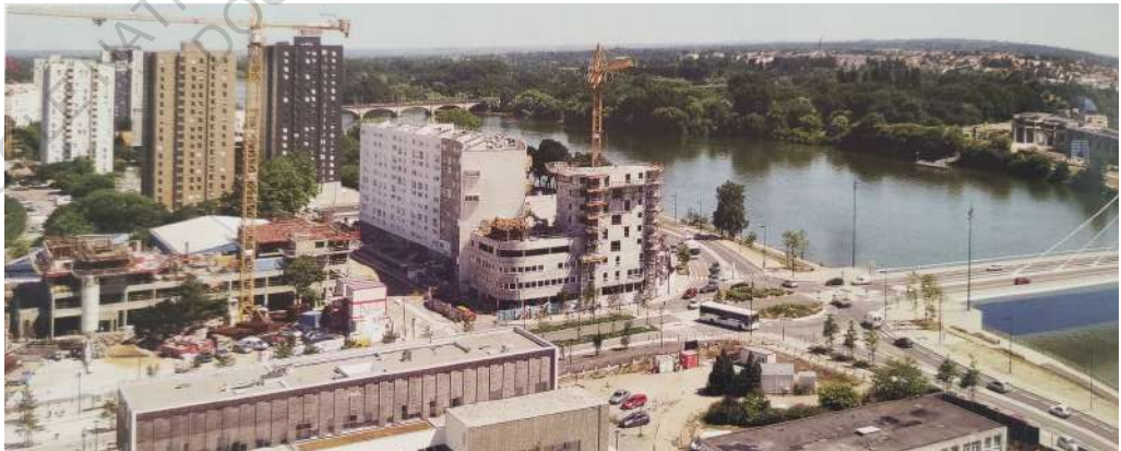
Démolition partielle du Linéaire d'Angleterre et restructuration de Rosa Parks - Le Retour en Ville - Nantes, Malakoff Pré Gauchet - 1 mai 2014 de Frédérique de Gravelaine
