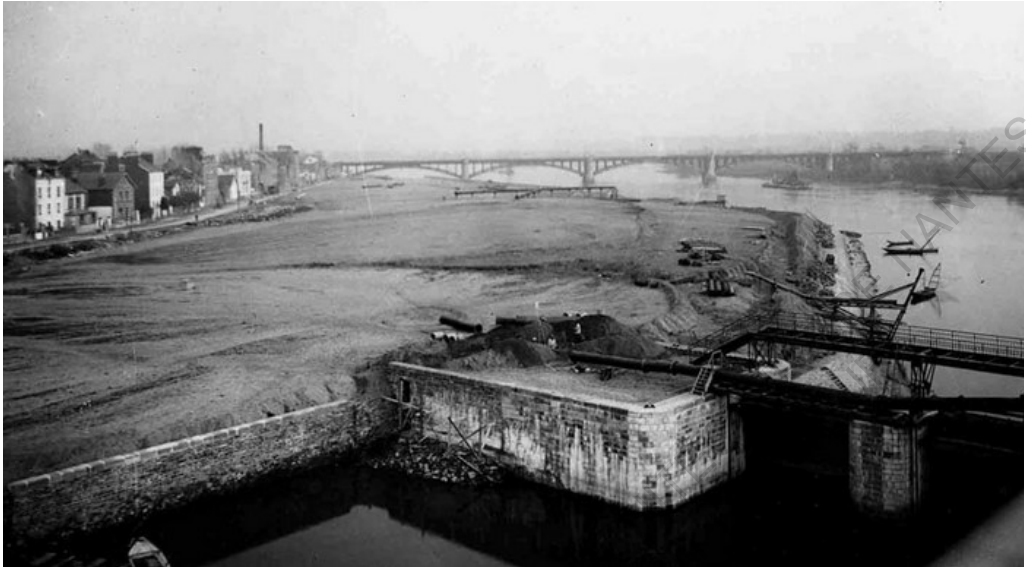
Remblais pour le stade marcel saupin - 1933
