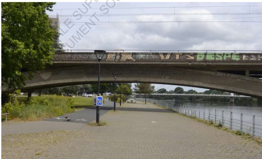
Bords de Loire de Malakoff après le réaménagement du franchissement - 2022 - Nathan Chasseloup
