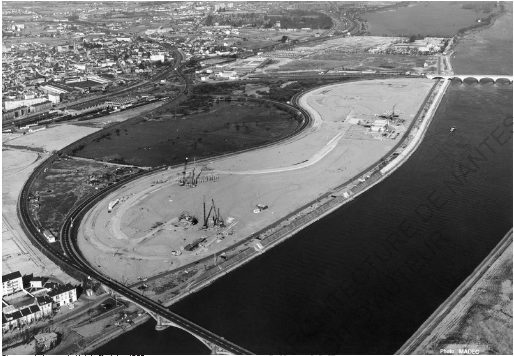
Chantier de la cité de Malakoff- début 1967
