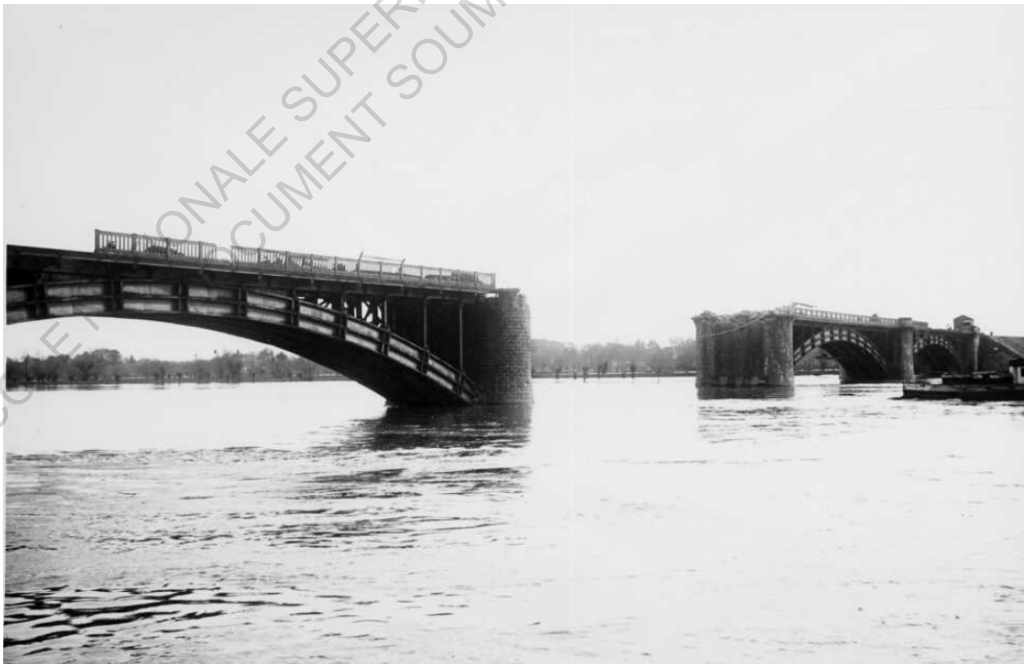
Pont Résal détruit - patrimonia.nantes.fr
