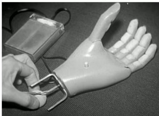
Figure 71 – Présentation de la main électro-commandée, 1954
