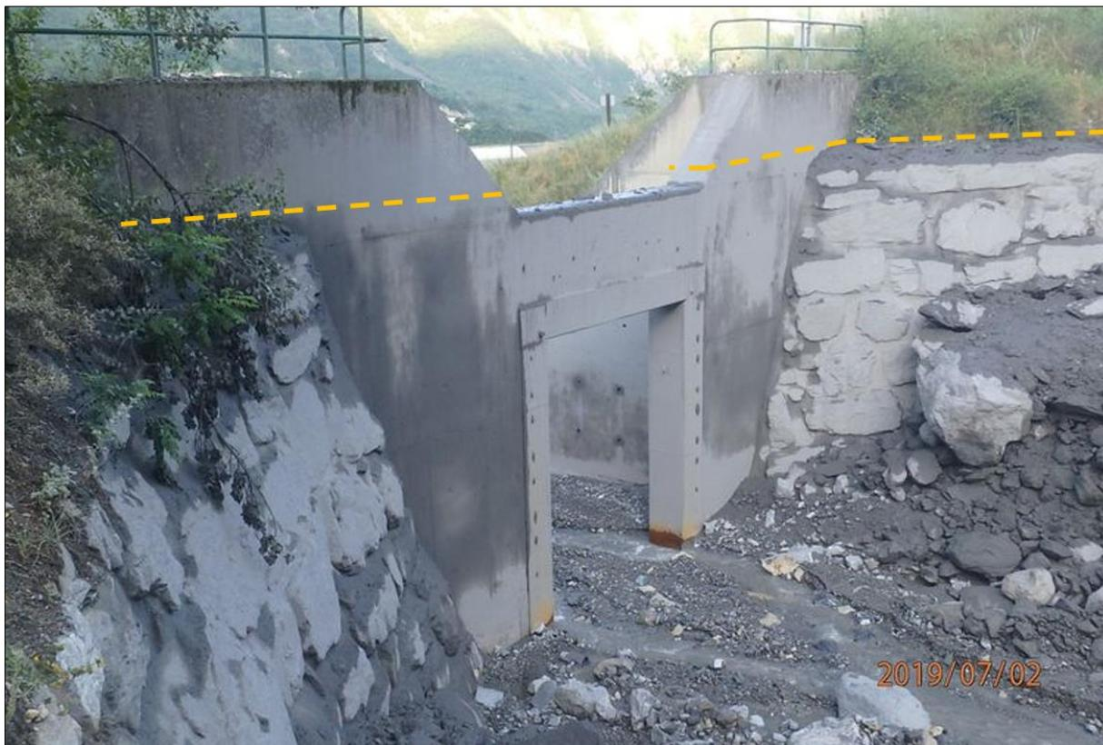
*Figure 35 : Laisses de crue apparentes sur le barrage filtrant et sur les digues latérales en enrochements (photo RTM73, 02/07/2019).*
