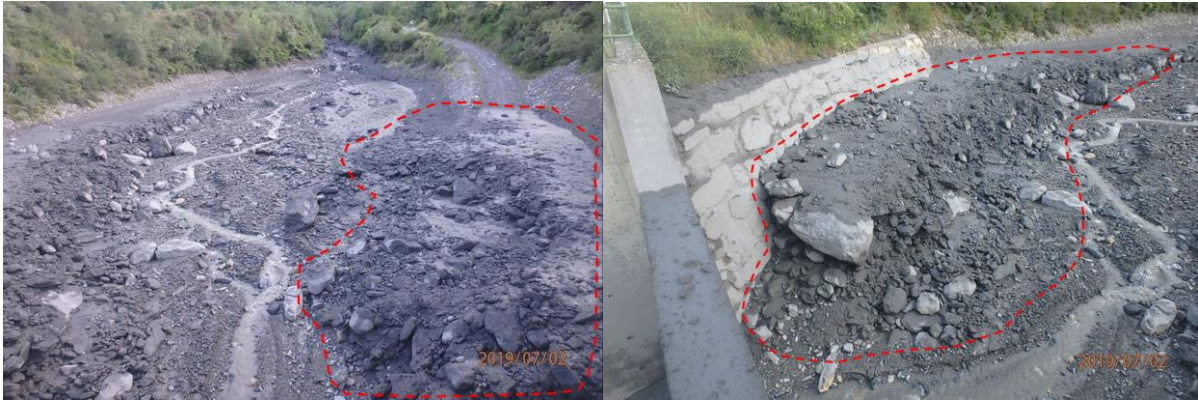
Figure 37 : A gauche : dépôts latéraux résiduels en rive gauche après le passage de la lave torrentielle du 1 er juillet 2019 (photo RTM73, 02/07/2019). A droite : dépôts latéraux résiduels en rive droite (photo RTM73, 02/07/2019).
