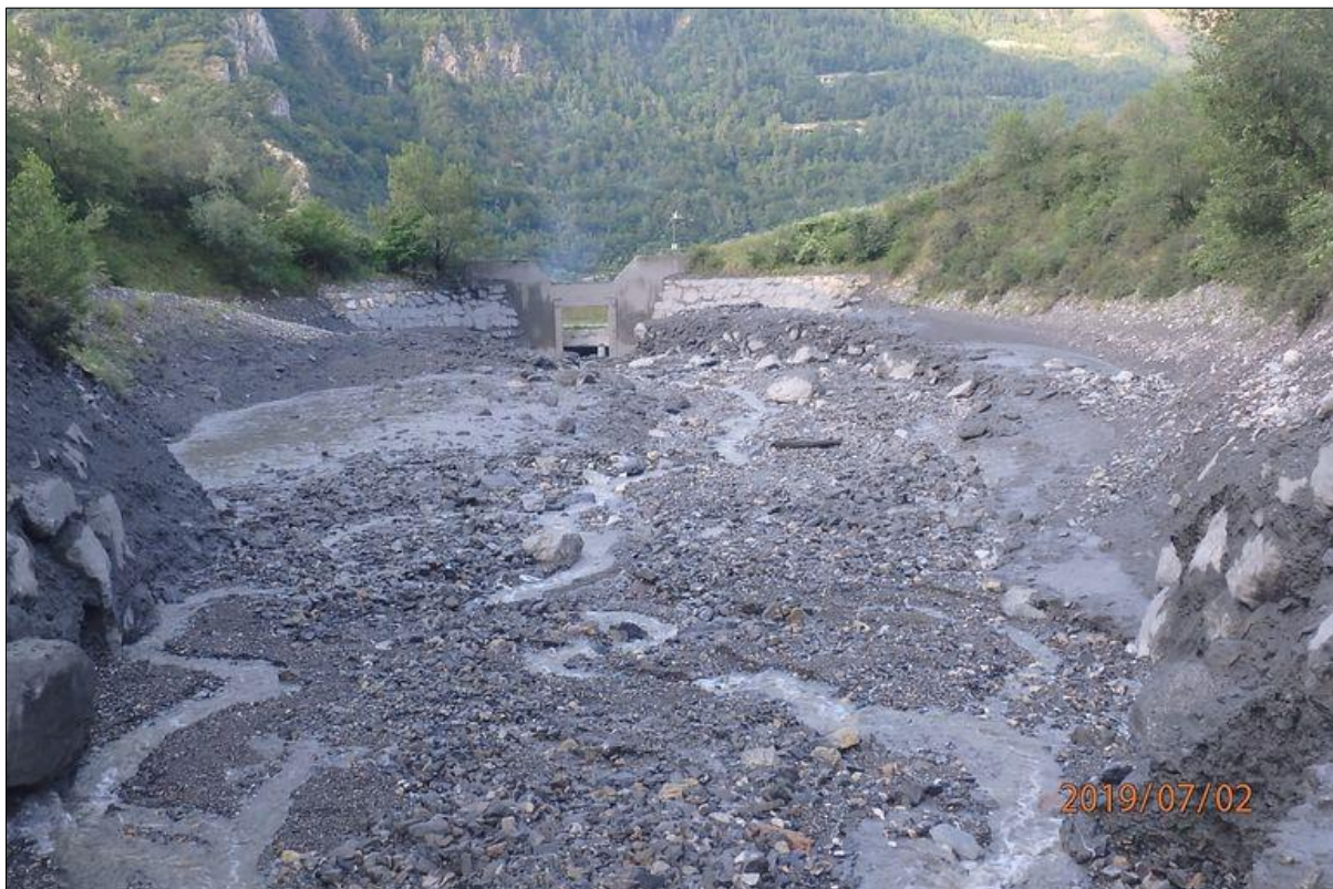
Figure 36 : Etat final de la plage de dépôts après le passage de la lave torrentielle du 1er juillet 2019 (photo RTM73, 02/07/2019).
