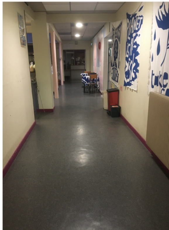
Couloir de l'atelier bois vers le hall du BAM
