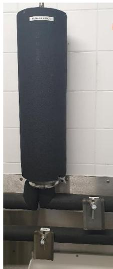
*Figure 19 : Ultrafiltre de 0,22  $\mu\text{m}$*
