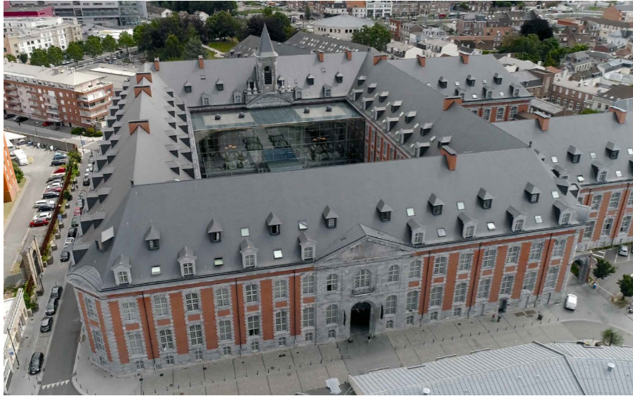
Figure n°25 - Restauration de la toiture d'origine
