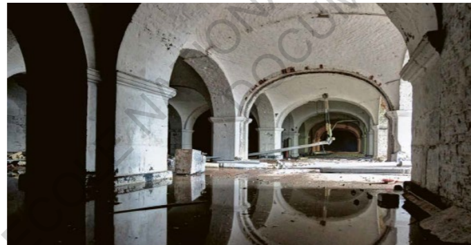
Figure n°29 - Espace avant la reconversion en piscine
