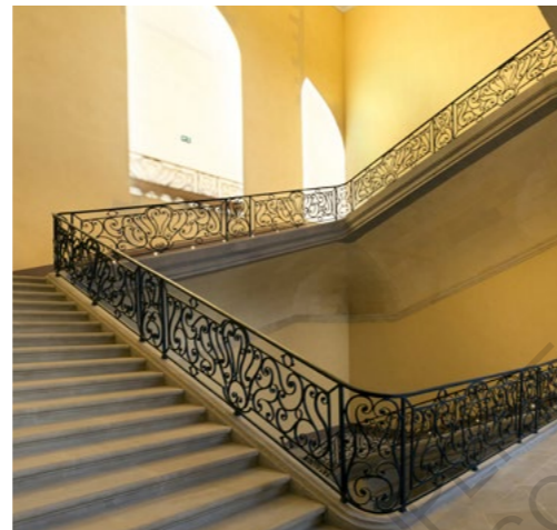
Figure n°39 - Escalier d'honneur restauré
