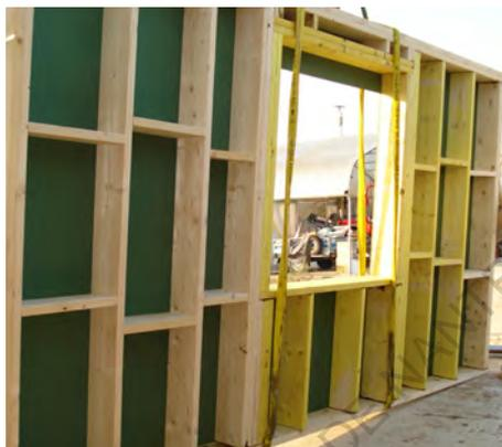
Fixation de panneaux hydrofuges de contreventement extérieur à l'ossature
