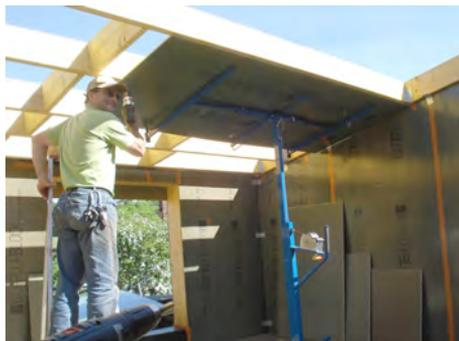
Fixation de panneaux hydrofuges pare-vapeur sous les poutres et entretoises de la charpente
