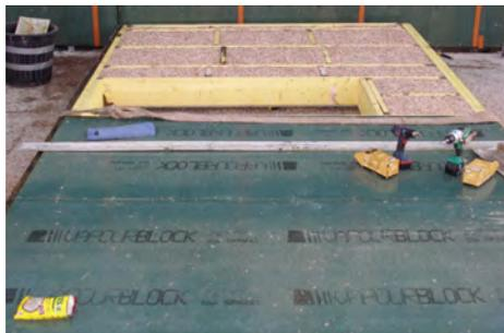
Fermeture du mur avec des panneaux hydrofuges et pares-vapeur
