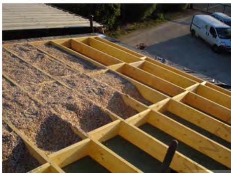
Remplissage des caissons de la charpente de miscanthus en vrac au godet
