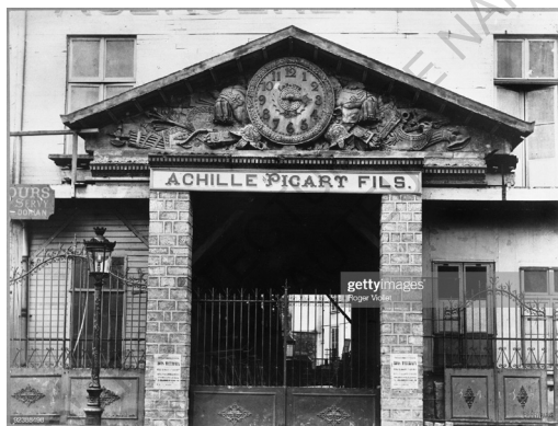
5. Entrée de l'entrepôt Achille Picart dont le fronton est celui du Palais des Tuileries
