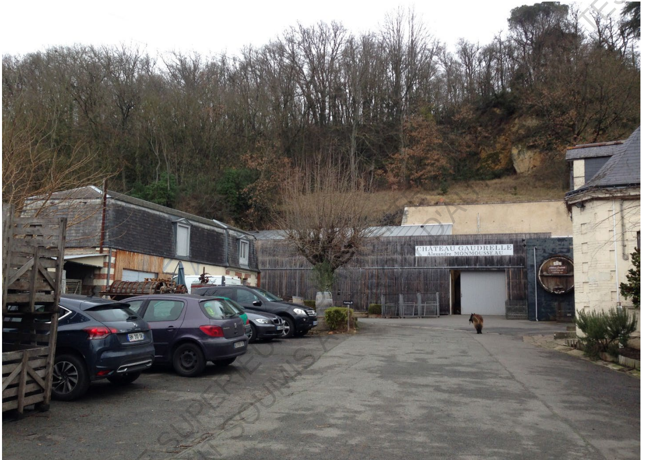
Figure 48 : Vue d'ensemble du domaine depuis l'accès principal
