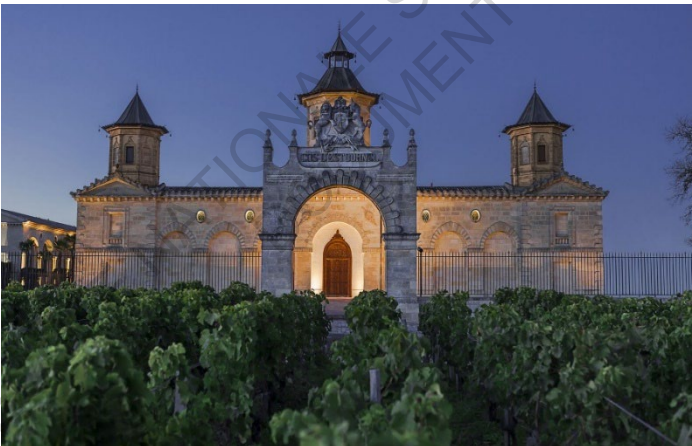
Figure 24 : Vue de l'entrée principale du domaine
