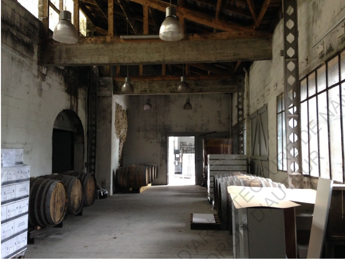
Figure 49 : Vue de la pièce existante à aménager en salle de degustation
