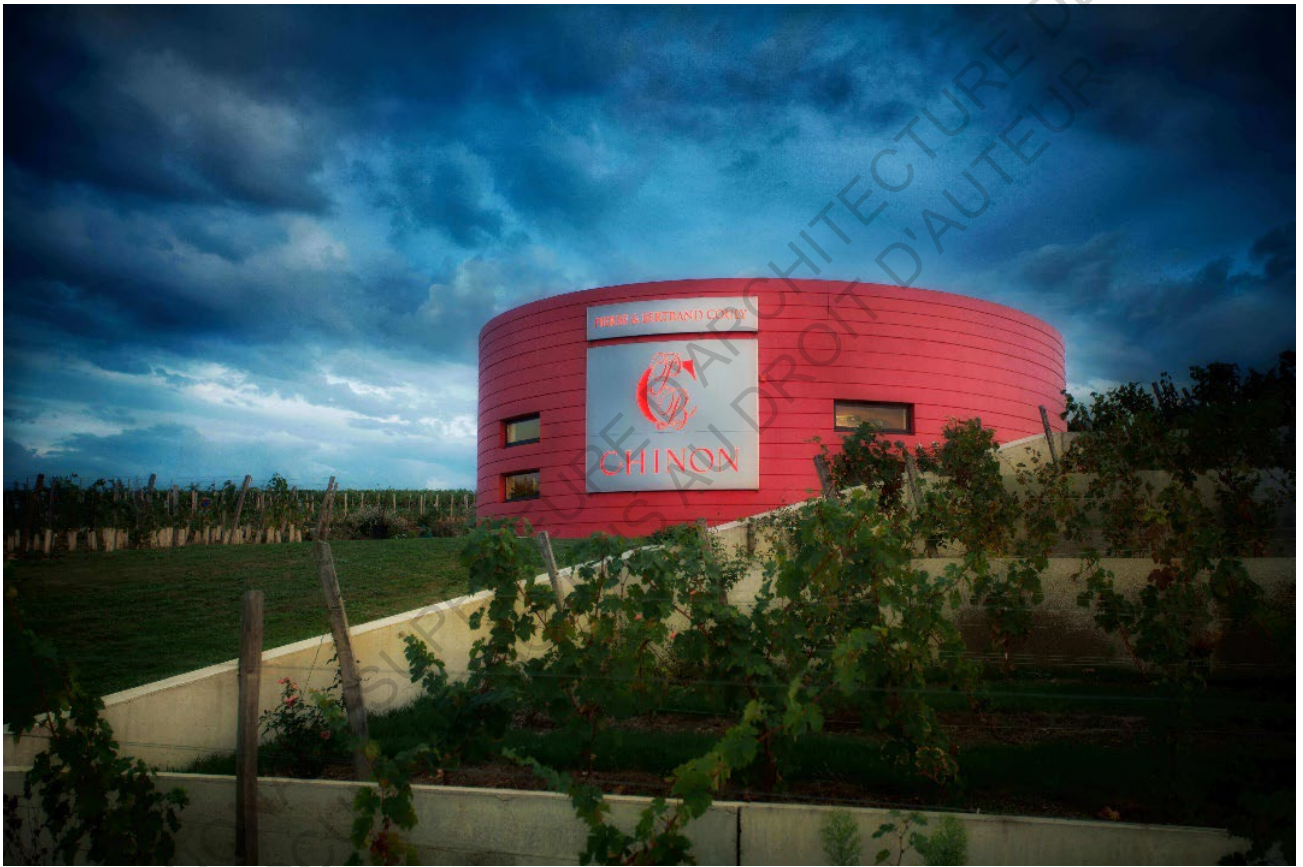
Figure 47 : Vue depuis le rond point du nouveau chai du domaine Couly
