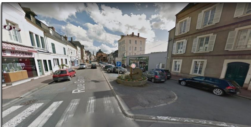
Figure 85 : Rue grande (Orbec avant travaux) tranche 1 (Google Earth)
