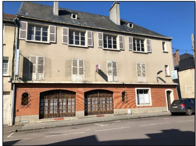
Figure 50 : Commerce et logements vacants à Saint Pierre en Auge le 09/03/2022
