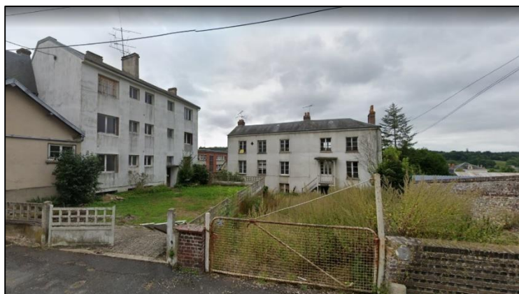
Figure 54 : Petits collectifs vacants et dégradés à Orbec le 12/03/2022
