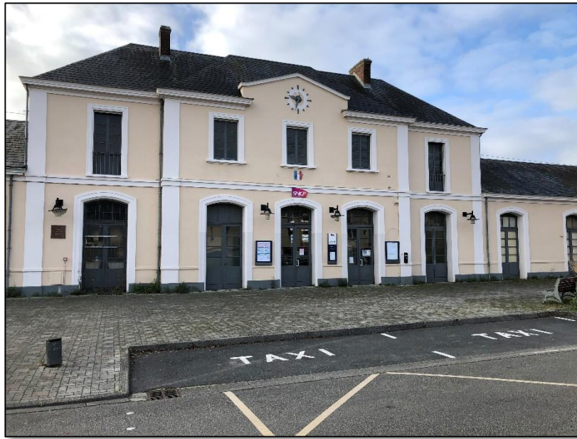
Figure 61 : Gare de Mézidon Vallée d'Auge 2022
