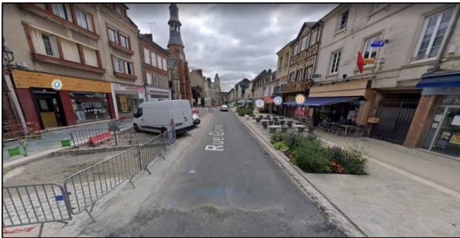
Figure 87 : Rue grande (Orbec avant travaux) tranche 3 (Google Earth)
