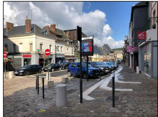
Figure 88 : Rue grande (Orbec après travaux) tranche 3 2022
