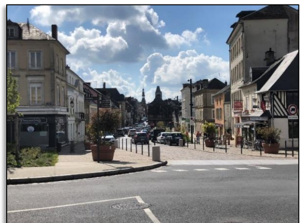
Figure 86 : Rue grande (Orbec après travaux) tranche 1 2022
