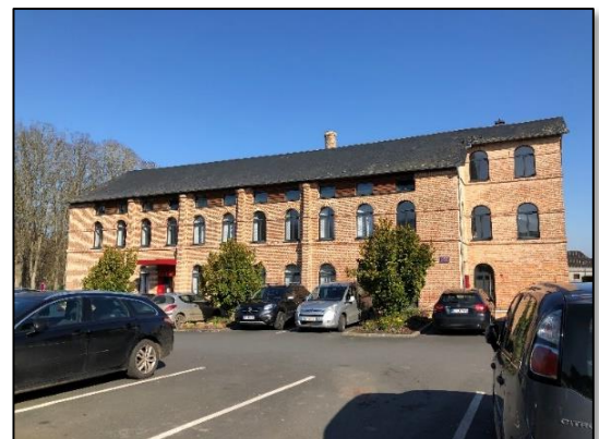
Figure 90 : Usine Leroy après réhabilitation ici devant le pôle de santé 2022
