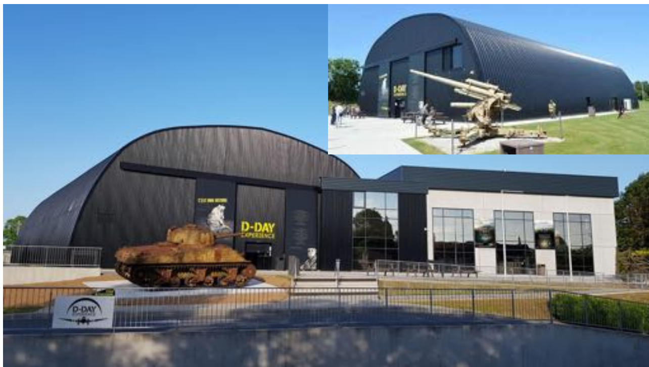
FIGURE 10 : Le hangar du D-Day Experience derrière l'ancien musée, avec la nouvelle salle de cinéma. Devant eux un char M4 Sherman ainsi que le canon Flak 36 de 88mm (en haut à droite) Source : Normandy Warguide (en haut) et Musée D-Day Experience
