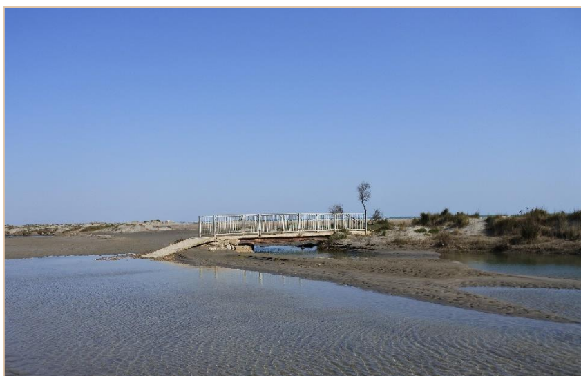
Photographie 2 : Ancienne passerelle témoin de l'érosion sur le secteur de la plage Est, auteur : TRIAY Lucas, 2022
