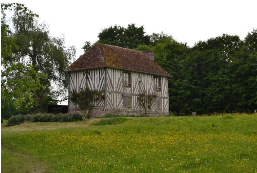
Photographie 9 : Maison en brique et colombage typique du Pays d'Auge à Saint-Gervais-des-Sablons (Adrien Picco, 2022)
