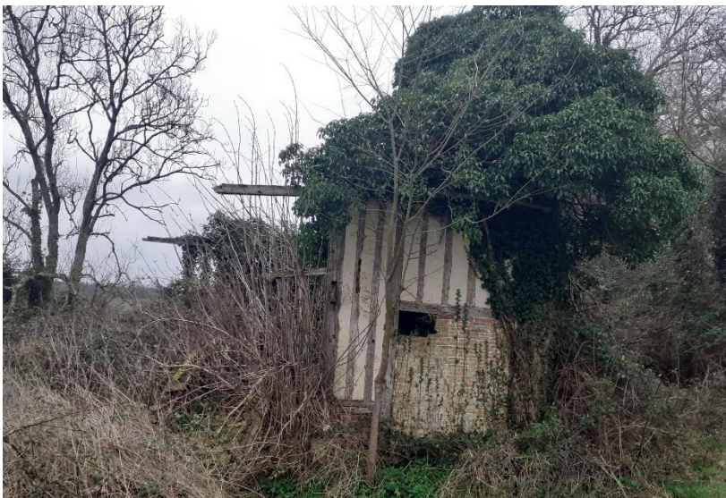
Photographie 15 : Bâtiment isolé détruit par la tempête de 1999 à Saint-Gervais-des-Sablons (Adrien Picco, 2022)
