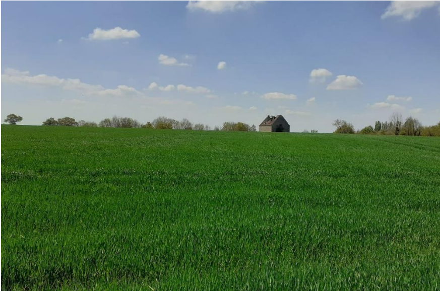
Photographie 14 : Bâtiment agricole isolé en pierre calcaire à Montreuil-la-Cambe (Adrien Picco, 2022)
