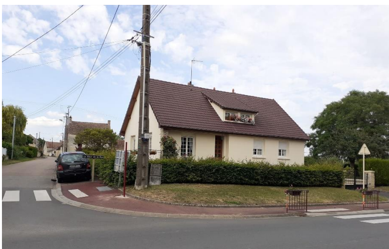
Photographie 12 : Pavillon construit à Fontaine-les-Bassets (Adrien Picco, 2022)
