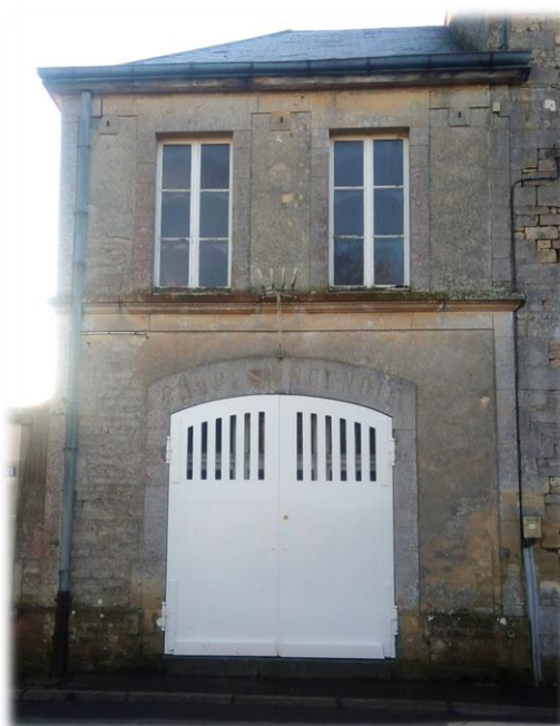
Photo 36 : Ci-dessus, ancienne mairie de Cully, photographie prise par EDELINE Antoine, le 14/01/2022
