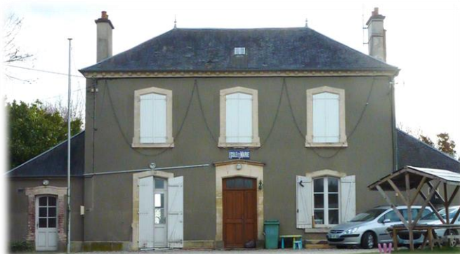
Photo 46 : Ancienne mairie de Berville réhabilitée en maison d'habitation photographie prise par Edeline Antoine le 22/02/2022
