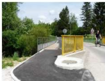
Prise en compte des modes doux dans les aménagements récents, extrême nord de la rue du Tacot, Rioz
