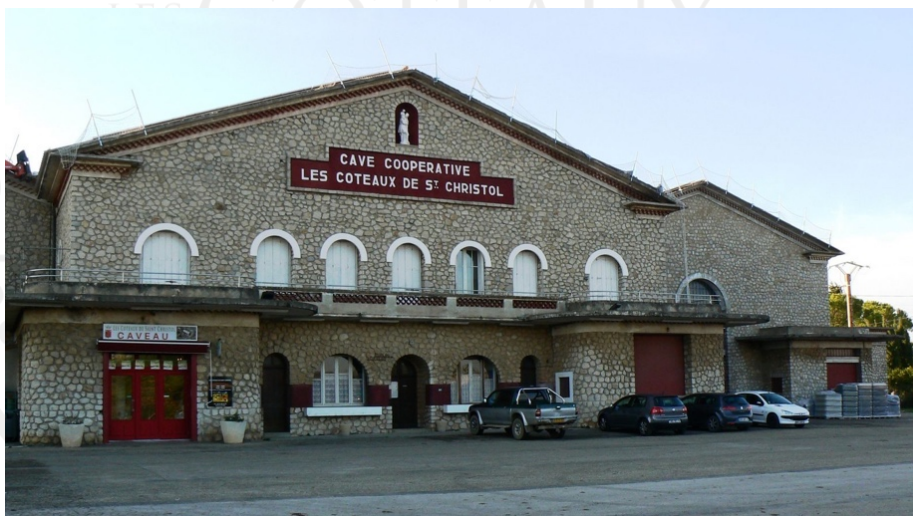
Figure 1 – Photographie de la façade de la cave coopérative
