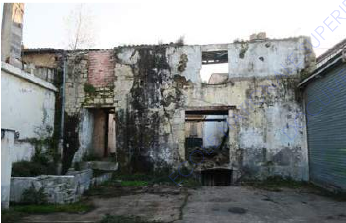
Figure 22: Présence du mur d'enceinte Dauphins Architecture
