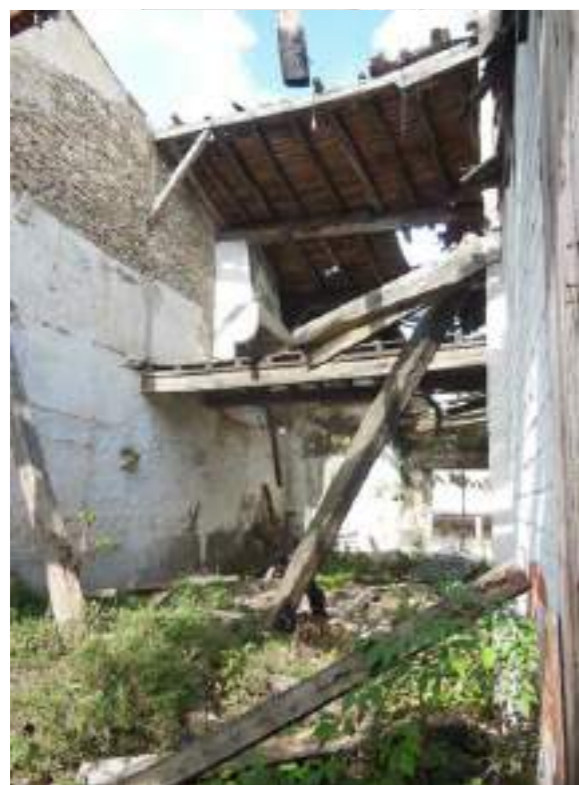
Figure 25: Photographie de l'immeuble Dupin "D", état existant Dauphins Architecture
