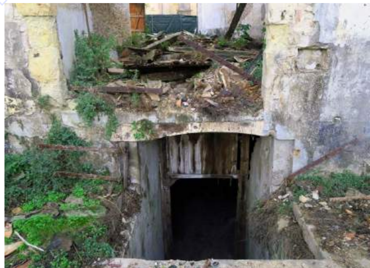
Figure 28: Passage vers cave des entrepôts Dauphins Architecture
