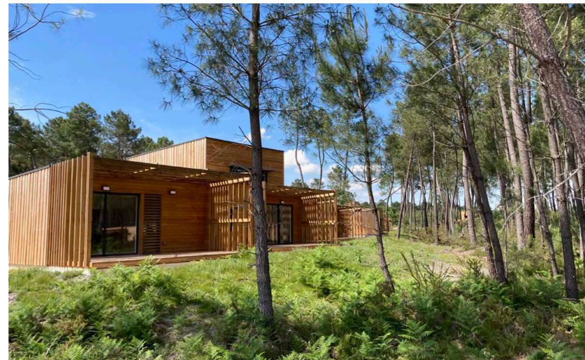
Figure 21 : Préservation maximale de l'espace boisé, seul l'implantation du bâti a nécessité un défrichage Source : photographie personnelle réalisée lors de la visite du chantier en compagnie des élus locaux en Juin 2021
