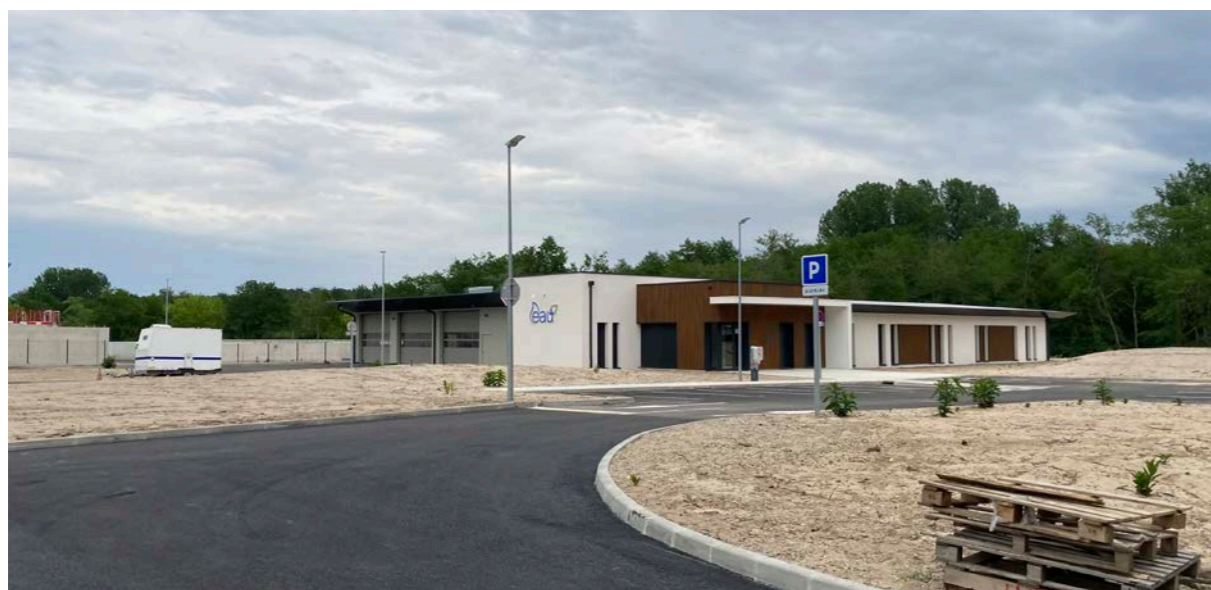
Figure 27 : La nouvelle station d'épuration construite pour répondre aux besoins du Center Parcs Source : photographie personnelle réalisée en mai 2021
