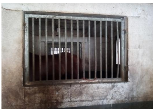
Figure 19 : Fenêtre avec une grille entre deux boxes (photographie personnelle).
