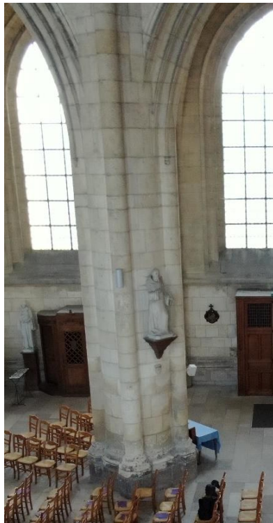
Figure 32 : Vue d'une pile de la nef de l'église Saint-Pierre. ©Maxence Toubin
