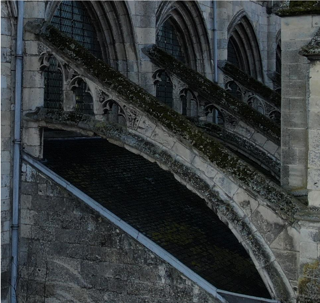
Figure 35 : Vue d'un arc-boutant du côté nord de l'église Saint-Pierre. ©Maxence Toubin
