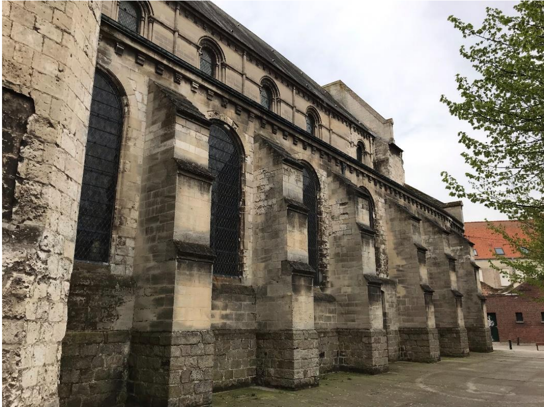
Figure 73 : Vue du collatéral nord de la collégiale Saint-Omer de Lillers (Pas-de-Calais). ©Maxence Toubin
