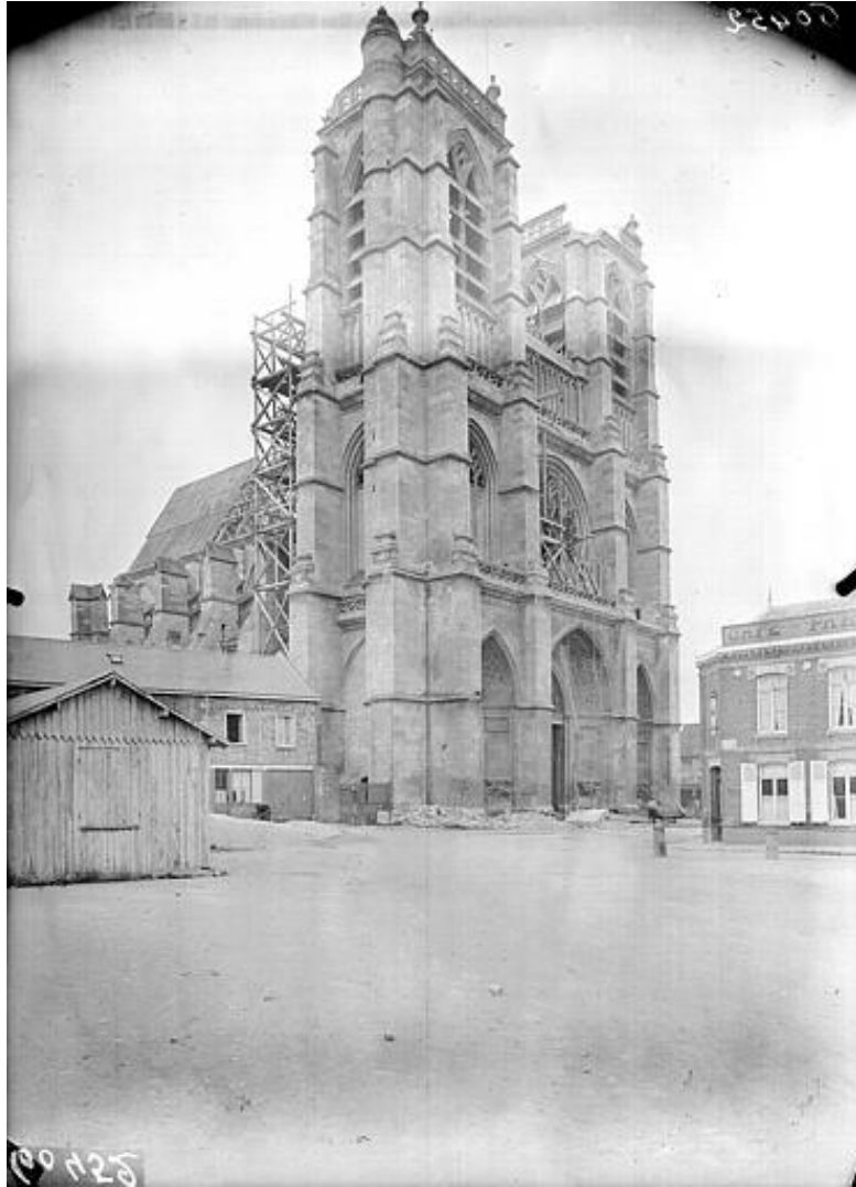
Figure 45 : Photographie anonyme du chantier de restauration de l'église Saint-Pierre, façade occidentale, 1921
