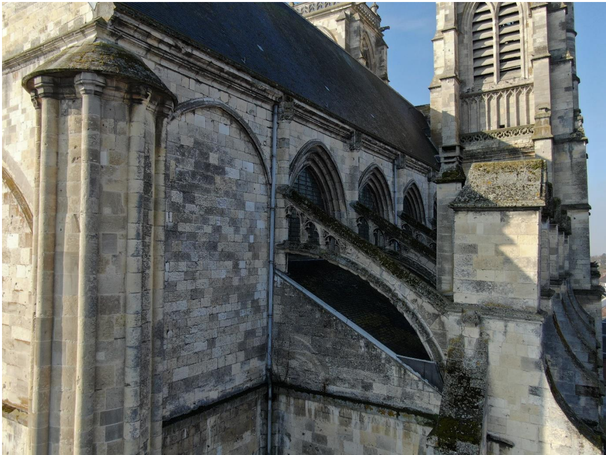
Figure 17 : Vue des chapiteaux des piles de l'ancien transept et de la façade latérale nord de l'église Saint-Pierre. ©Maxence Toubin
