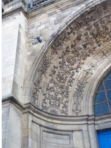
Figure 3 : La façade occidentale de l'église Saint-Pierre en cours de relevé. ©Maxence Toubin
