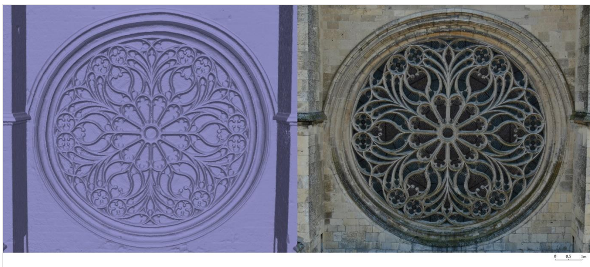
Figure 39 : Relevé photogrammétrique de la rose de la façade occidentale de l'église Saint-Pierre. ©Maxence Toubin
