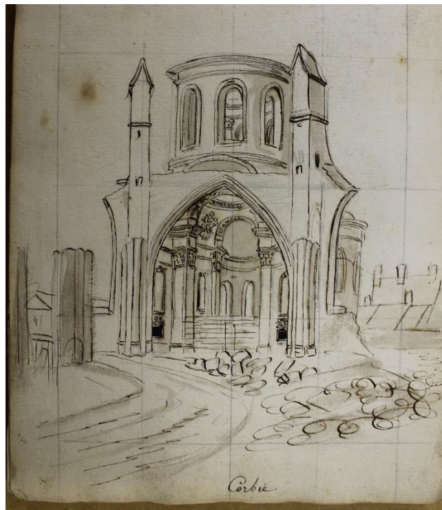
Figure 8 : Dessin de la chapelle des Corps-Saints en cours de démolition réalisé par L. Duthoit, 1823, Amiens, Musée de Picardie, Carnet Duthoit I 4
