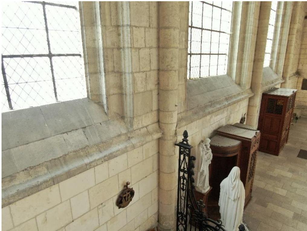
Figure 33 : Vue d'une colonne engagée dans le collatéral sud de l'église Saint-Pierre. ©Maxence Toubin
