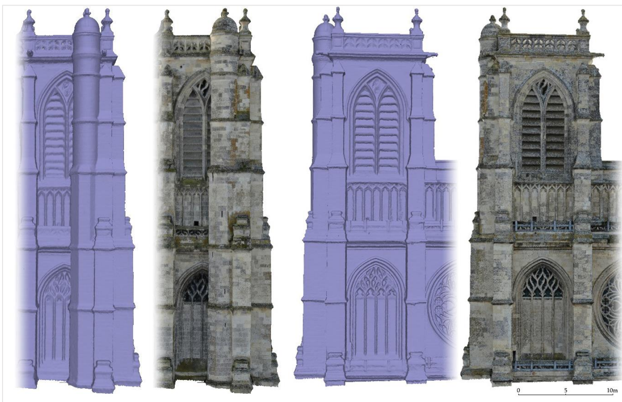
Figure 40 : Relevé photogrammétrique de la tour nord de l'église Saint-Pierre (vues des faces nord et ouest). ©Maxence Toubin
