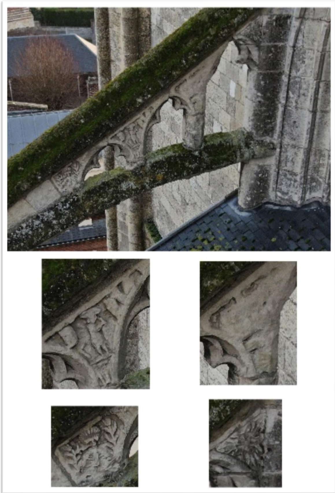
Figure 50 : Vue générale de la face ouest de l'arc-boutant n°1 et détails. ©Maxence Toubin
