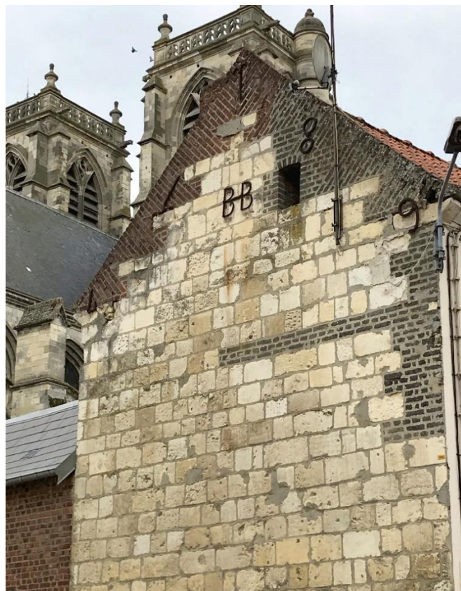
Figure 78 : Vue de la façade d'une maison rue Sadi-Carnot. ©Maxence Toubin
