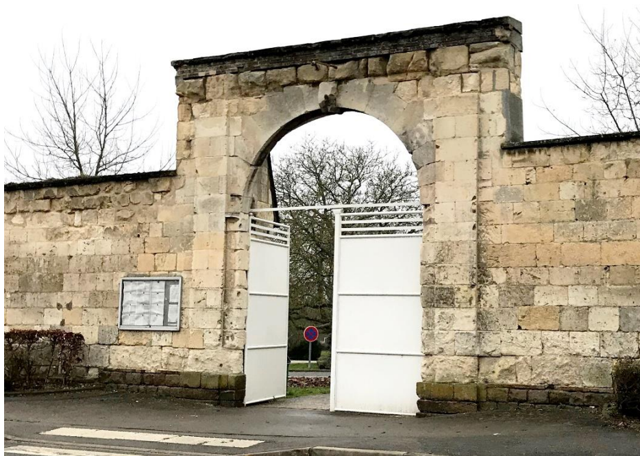
Figure 111 : Vue de la porte d'accès au nord-est du clos de l'abbaye. ©Maxence Toubin
