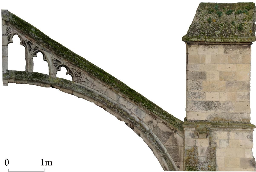
Figure 43 : Relevé photogrammétrique de la face est de l'arc-boutant situé à l'extrémité orientale du bas-côté nord. ©Maxence Toubin
