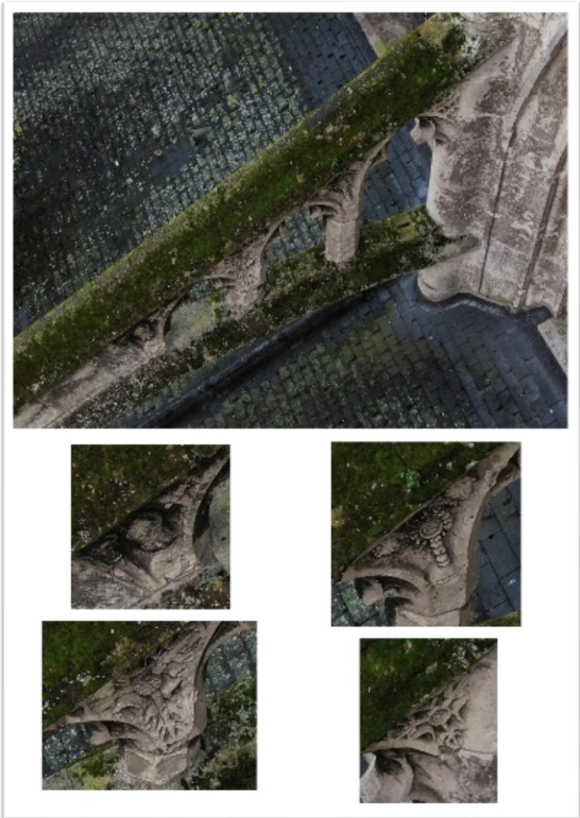
Figure 57 : Vue générale de la face ouest de l'arc-boutant n°3 et détails. ©Maxence Toubin
