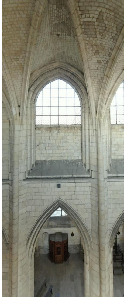
Figure 31 : Vue d'une travée de la nef de l'église Saint-Pierre. ©Maxence Toubin
