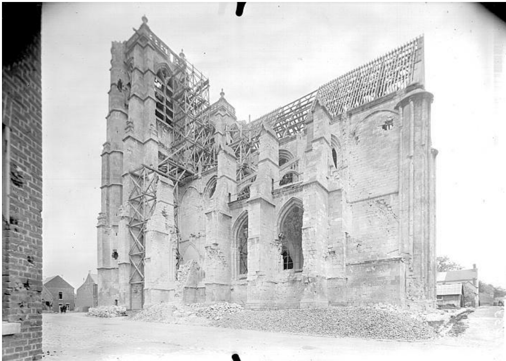
Figure 44 : Photographie anonyme du chantier de restauration de l'église Saint-Pierre, bas-côté sud, 1921
