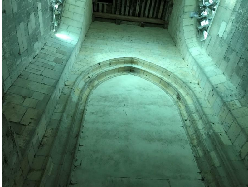
Figure 41 : Vue du mur nord de l'intérieur de la tour sud de l'église Saint-Pierre. ©Maxence Toubin
