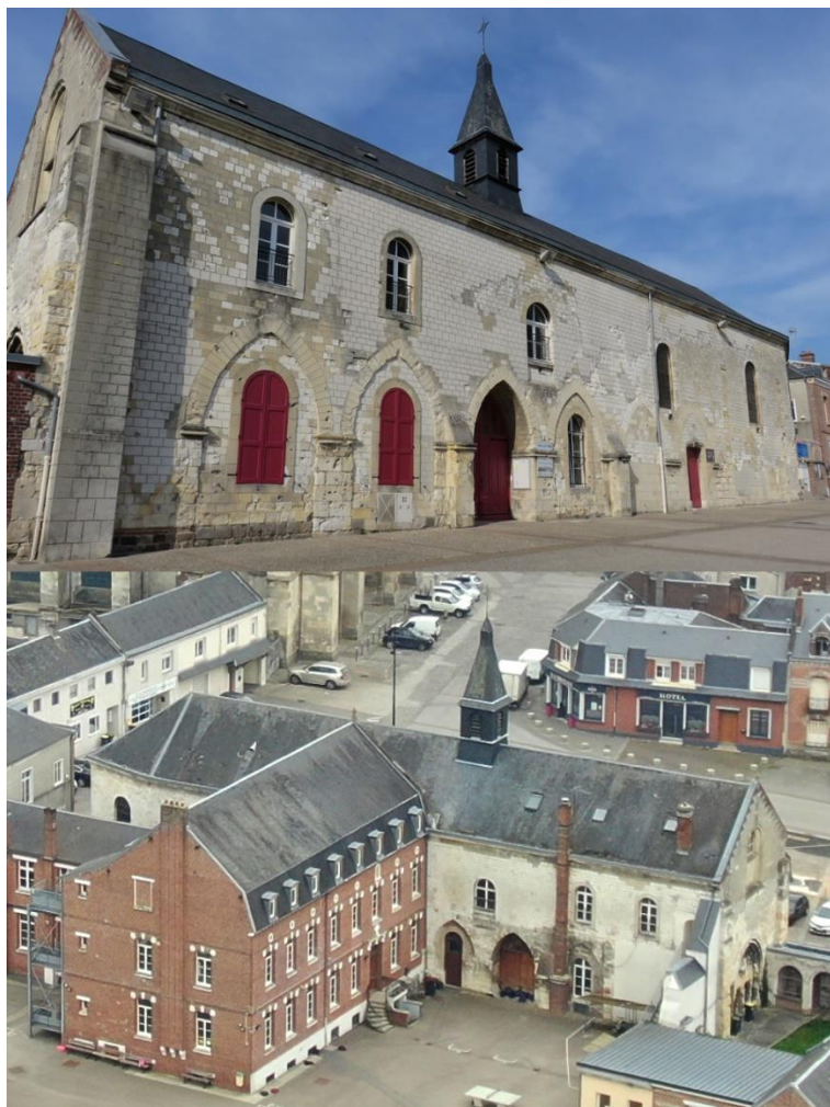
Figure 66 : Vues aériennes des façades nord et sud de l'église Saint-Étienne. ©Maxence Toubin
