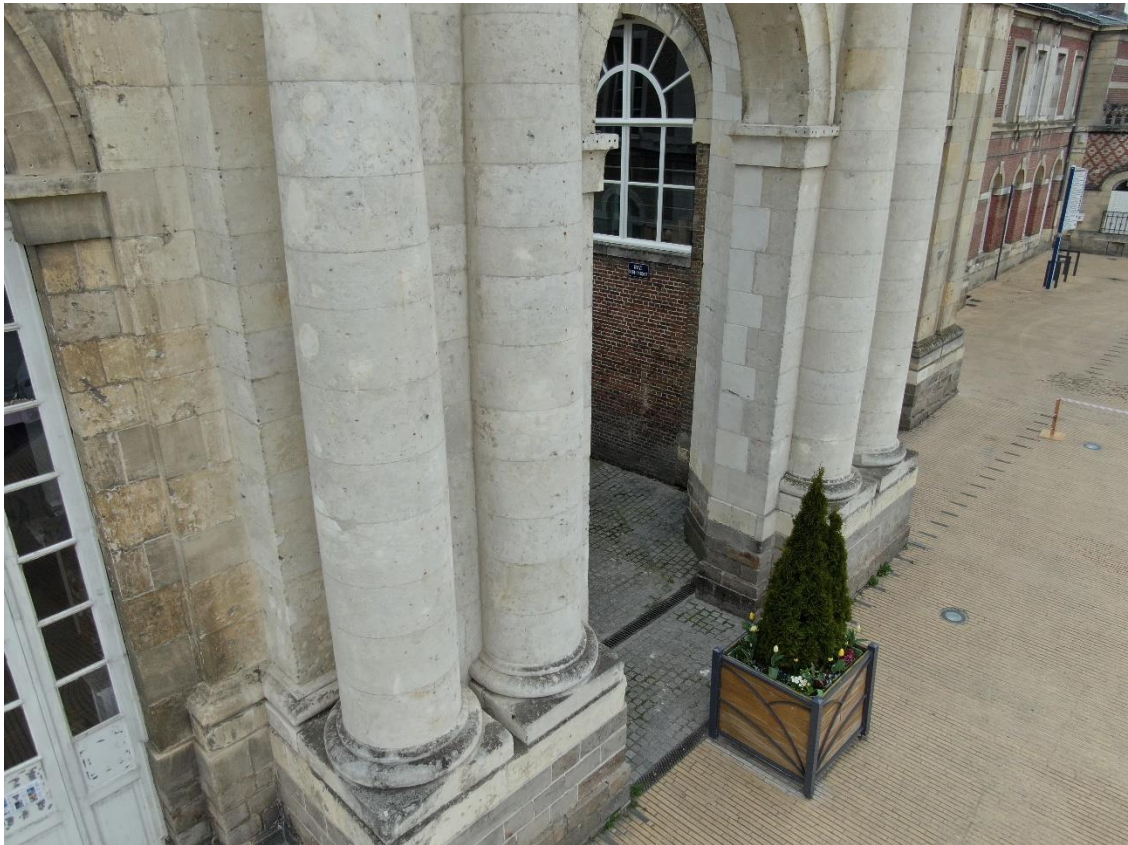
Figure 146 : Vue de l'élévation des soubassements de la porte monumentale de l'abbaye. ©Maxence Toubin
