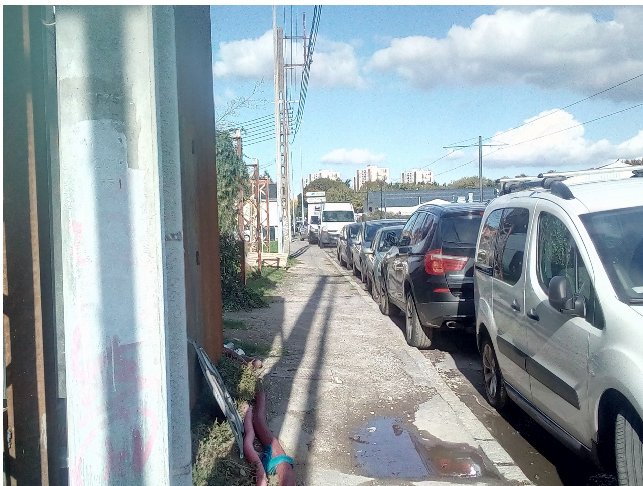
Illustration 17 : L'un des trottoirs dont se plaignent les vieilles personnes qui habitent la Halvêque. Ici entre Halvêque et Haluchère. Photographie réalisée en octobre 2019
