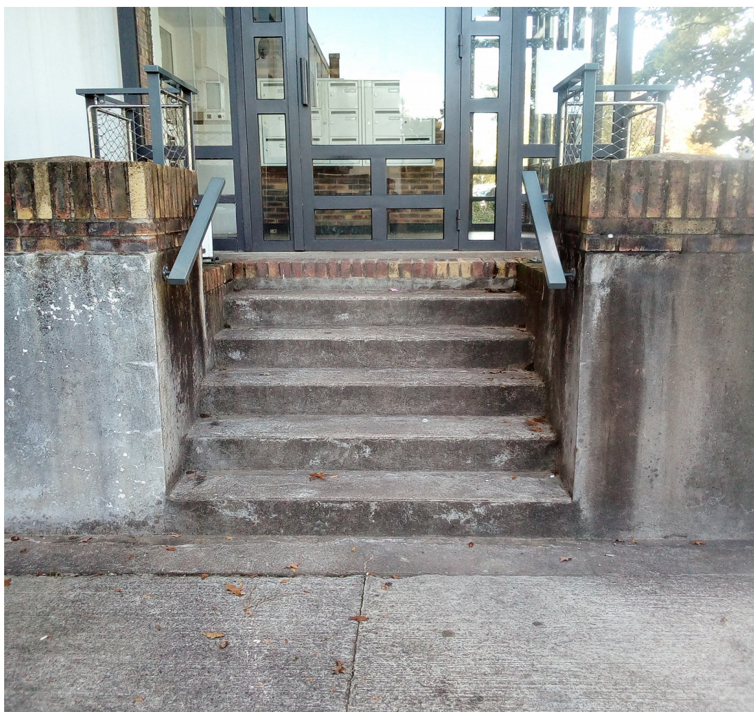
Illustration 18: L'un des obstacles signalés par certains vieux habitants : les escaliers des immeubles de moins de trois étages de la Halvêque. On voit que depuis l'entretien, une double rambarde a été installée. Source : Photographie réalisée en octobre 2019.
