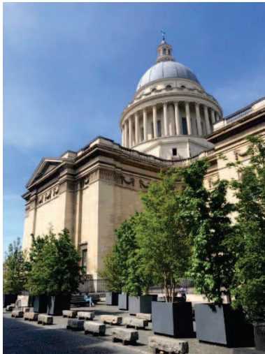
Arbres en pot, blocs de granit et assises sur le quart arrière droit du Panthéon.
