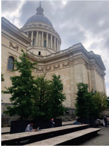
Un homme travaille sur son ordinateur sur une grande table en bois au niveau du quart arrière gauche.
