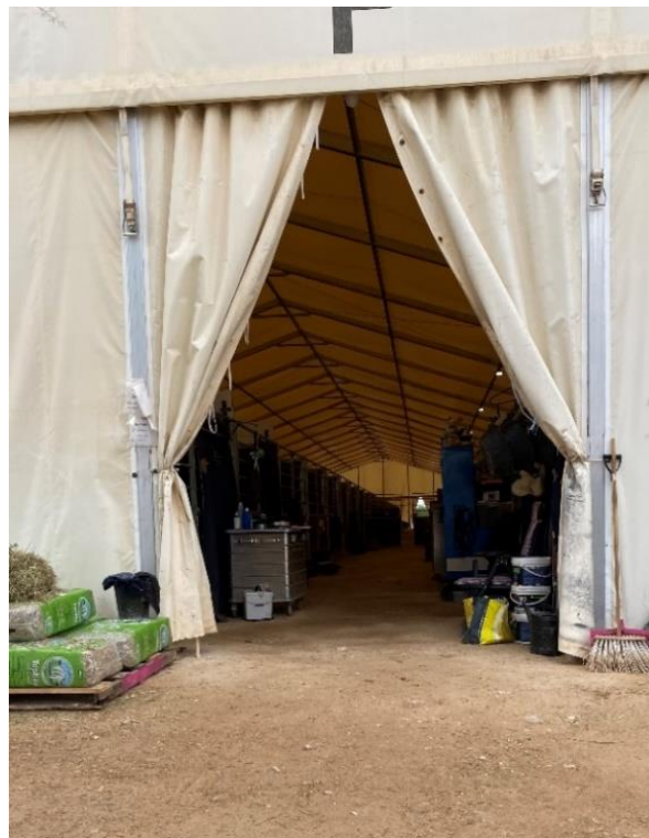
FIGURE 4 : OUVERTURE DE LA TENTE PERMETTANT L'AERATION. CREDIT PHOTO ANNE COUROUCÉ.
