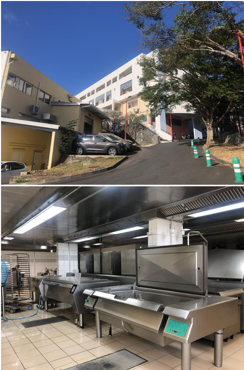
Figure 13 : Cuisine centrale du Lycée Bellepierre, Saint-Denis – vue extérieure et vue des équipements (photo autrice)
