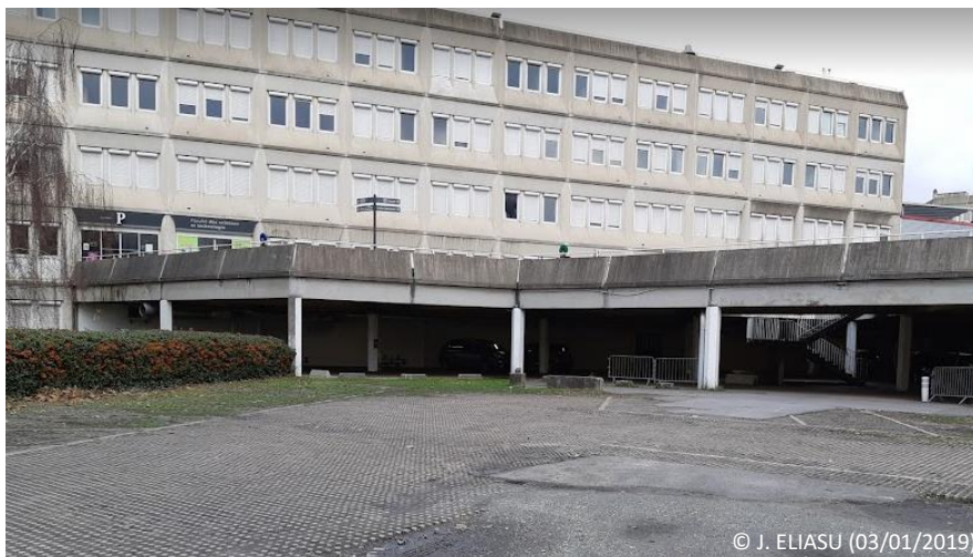
Photo 18 – Urbanisme sur dalle à Créteil, ici le parking de l'Université Paris Est-Créteil surmonté par une vaste dalle
