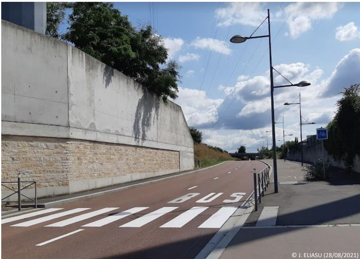
Photo 21 – Site propre de la ligne de bus 393 au niveau de l'arrêt « Basse Quinte », près du Carrefour Pompadour (Créteil)
