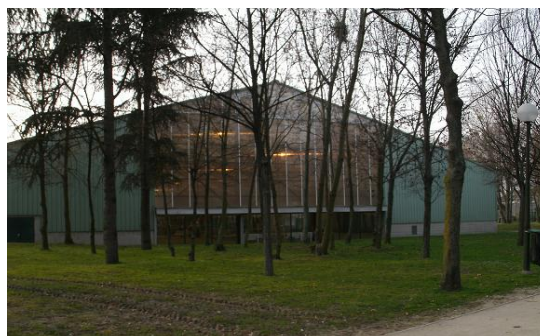
Photo 5 Le complexe A. Delaune (Parc des Sévines)
